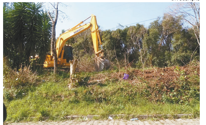
>> A previsão é a construção de 3.240 metros quadrados
