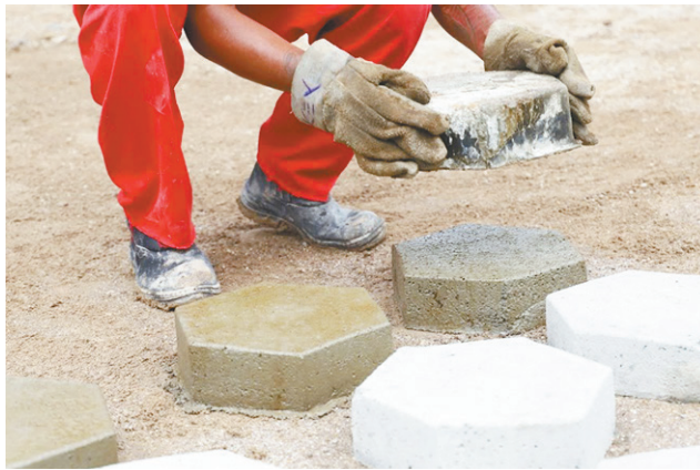
>> Apenados trabalhariam na pavimentação de ruas
