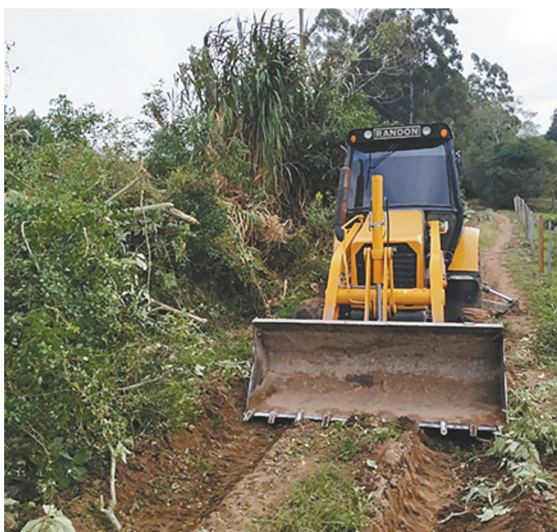
>> Retroescavadeira fez vários serviços
