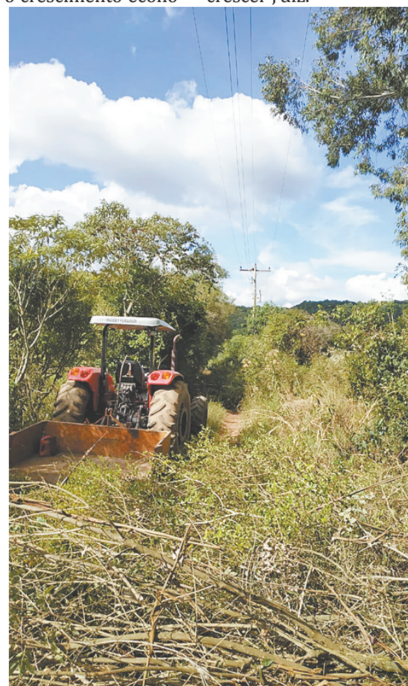
>> Máquinas auxiliaram no acesso às propriedades
