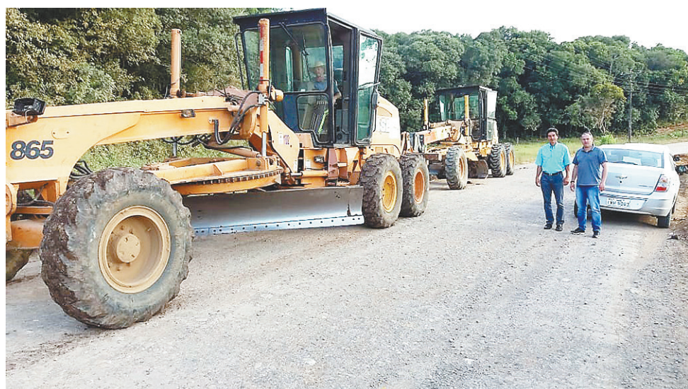
>> Prefeitos dos dois municípios vistoriaram os trabalhos na rodovia
