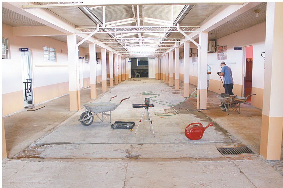
>> Ao todo, está sendo aplicados R$ 25 mil em obras de infraestrutura do local
