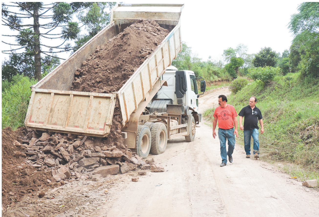
>> Prefeito Gilnei Luchese e secretário Tuia vistoriando as obras no interior de Lagoa Bonita do Sul
