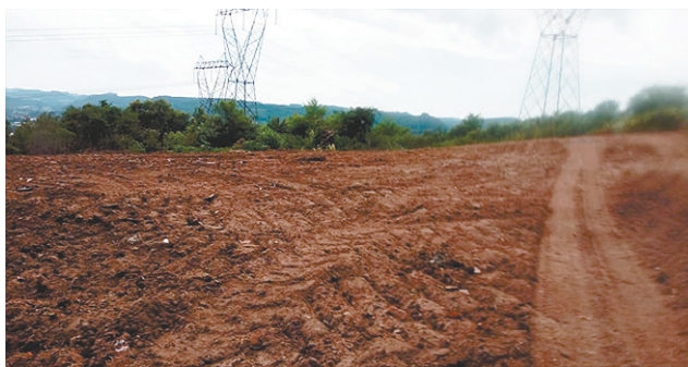
lhecimento de entulhos.
