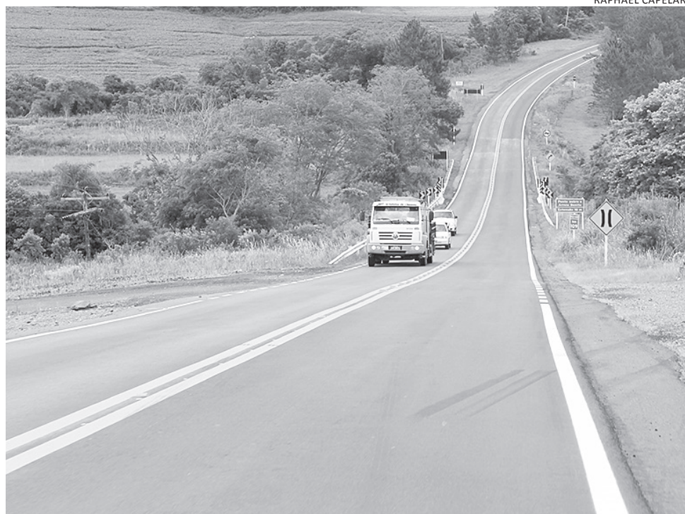
>> RSC-481: novo visual depois da recuperação
