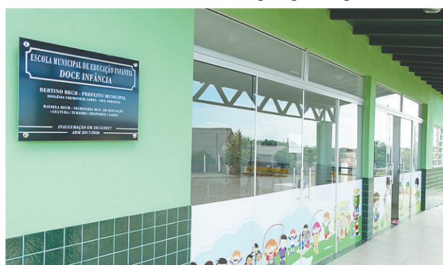
>> Toda a estrutura está nas normas
