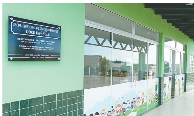
>> Toda a estrutura está nas normas
