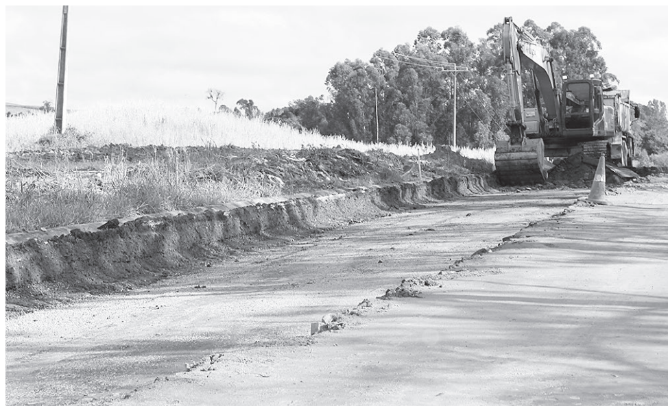
>> Máquinas intensificaram trabalhos no trecho que leva Sobradinho a Arroio do Tigre
