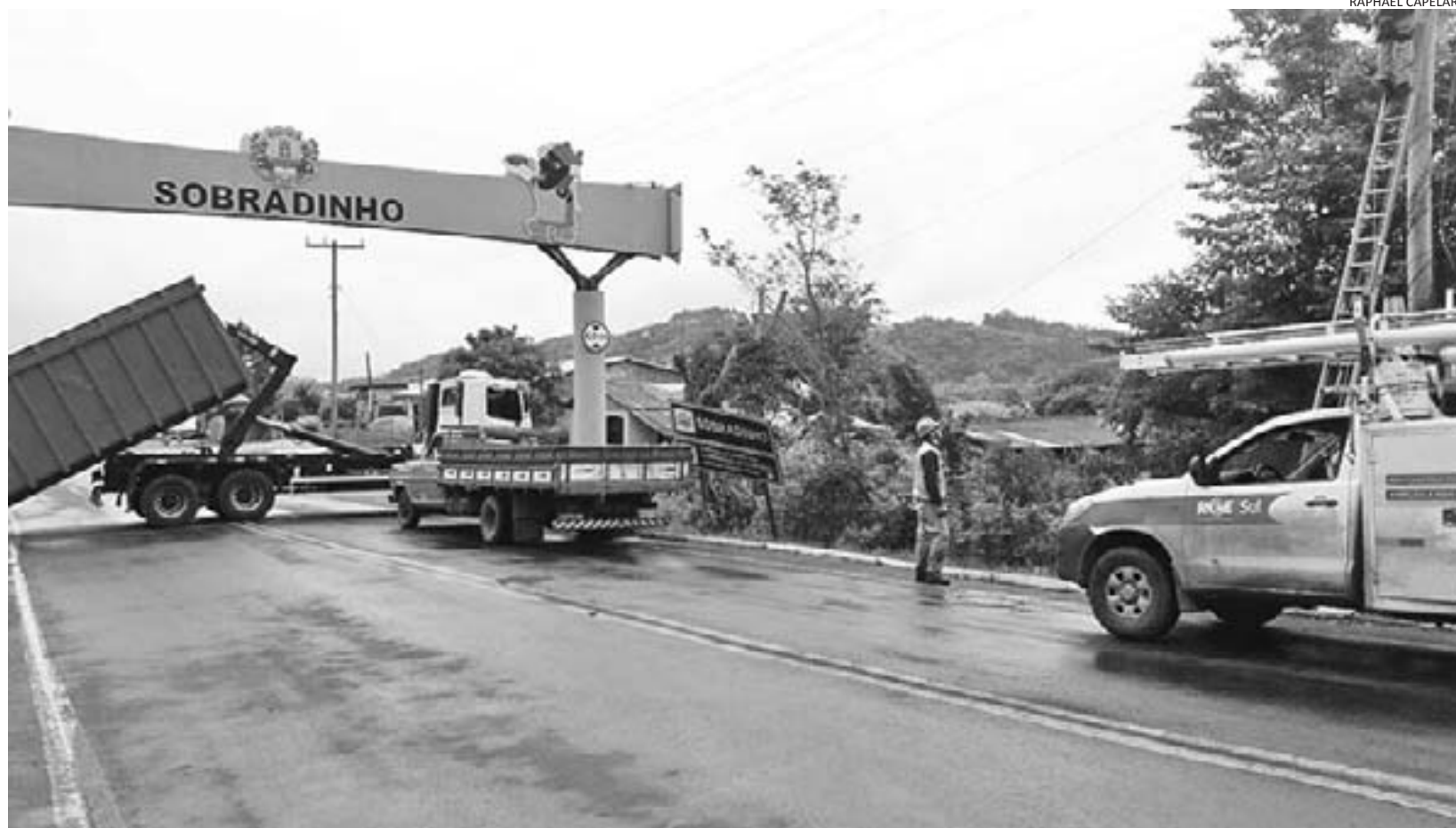
>> Enquanto trânsito estava bloqueado, equipe da RGE Sul trabalhava no restabelecimento da energia
