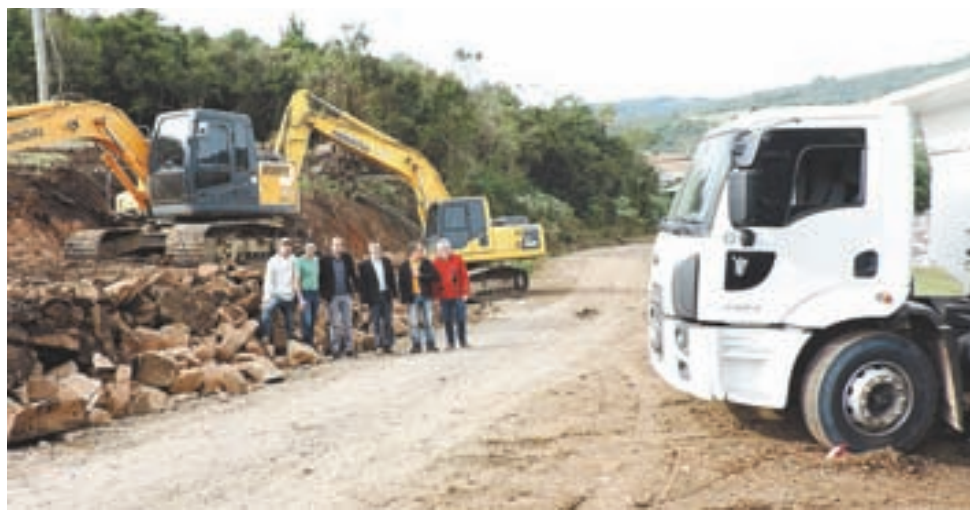
&gt;&gt; Alargamento da estrada no início do Distrito Industrial
