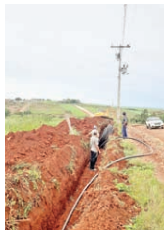
Instalação de redes de água;
