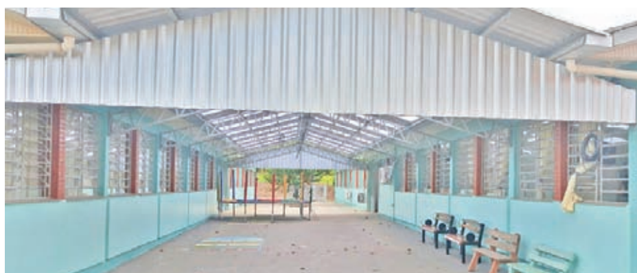
Instalação de cobertura entre os pavilhões da EMEF Álvaro Rodrigues Leitão;
