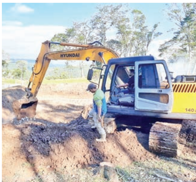
Execução do Programa de Horas-Máquinas, de incentivo à produção agrícola e melhoria das propriedades, para o qual foram licitadas 500 horas de escavadeira hidráulica;
