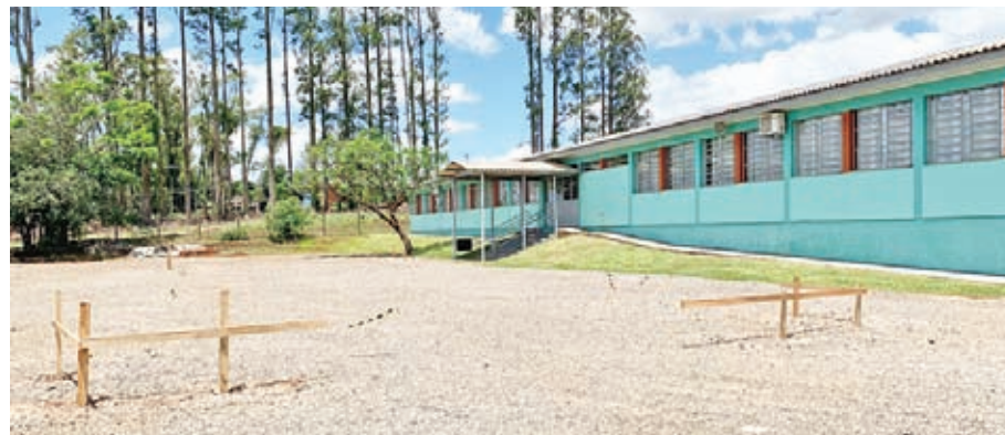
Licitada ampliação da EMEF Álvaro Rodrigues Leitão, para construção de Bloco E;
