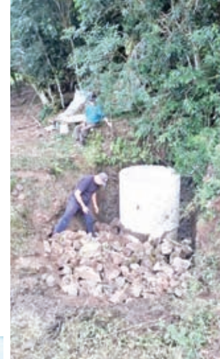
Instalação, limpeza e manutenção de fontes drenadas, para proteção de nascentes;
