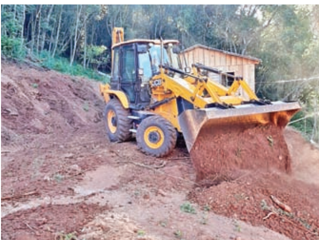
Manutenção da infraestrutura de propriedades rurais
