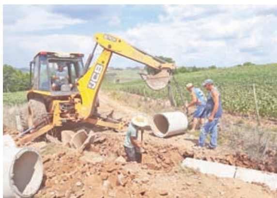
Instalação de bueiros com tubos de concreto, bem como limpeza e manutenção de bueiros e desaguadouros;
