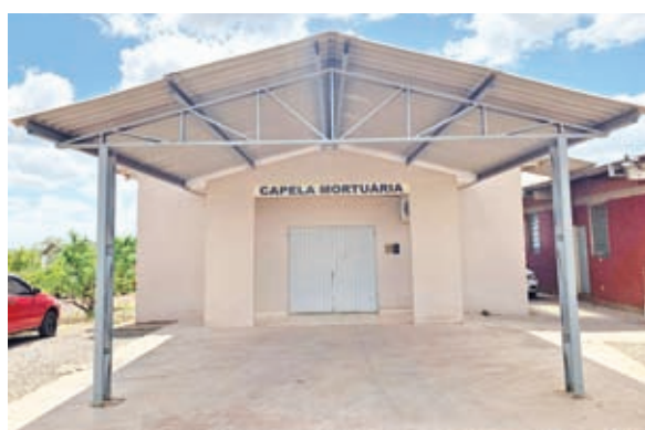
Ampliação da capela mortuária em 27m 2 , com colocação de cobertura (fachada e lateral);
