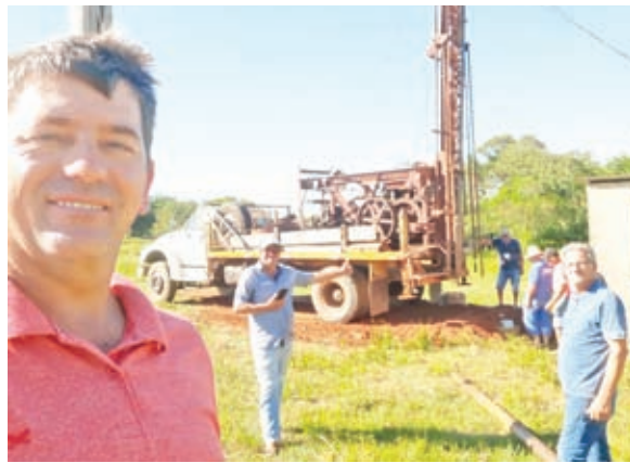
Limpeza e manutenção de poços artesanais;
