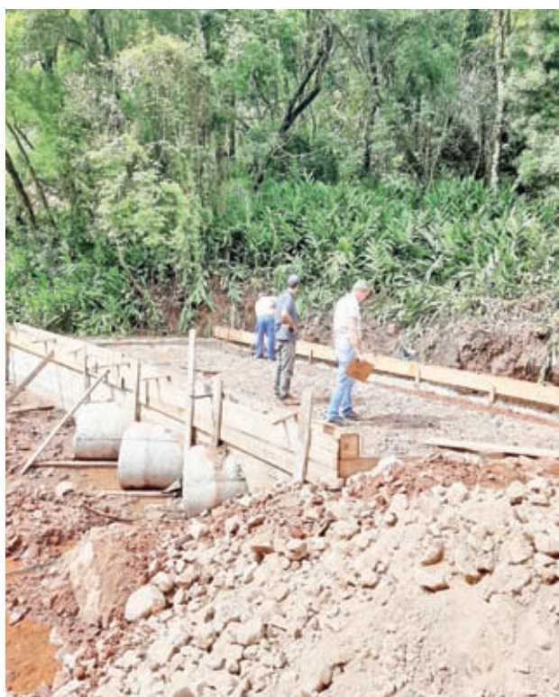
Construção de travessia com bueiros de grande vazão (ponte seca) no acesso à propriedade de Aírton Freese;
