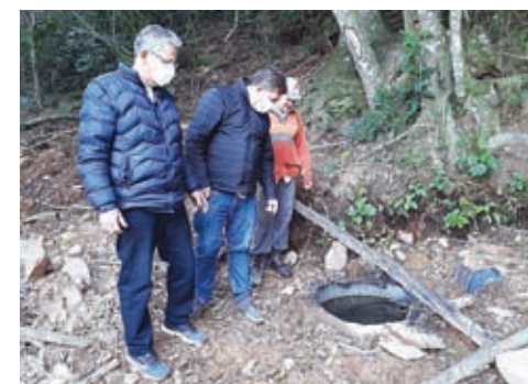
>>> Fonte drenada construída na propriedade de Gilberto Herber, na localidade de Linha Silveira
