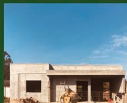
Execução de Obra Residencial
